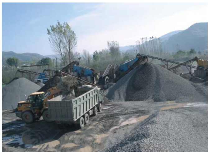
三门峡中铁三局郑西高速铁路砂石料生产
