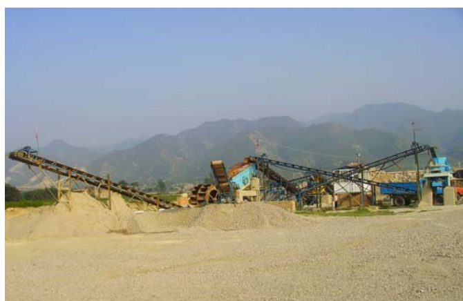
浙江湖州时产40方机制建筑砂生产线
